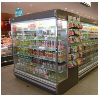
スーパーの中でも多くの電力を消費する飲料販売仕器に、扉付き冷蔵ケースを導入いたします。従来のオープン型の冷蔵ケースに比べ、電気使用量が 48% も削減でき、省エネ効果が大きく見込まれます。また冷気が漏れないことで空調循環が効率化され、売場の冷え対策にも効果的です。
